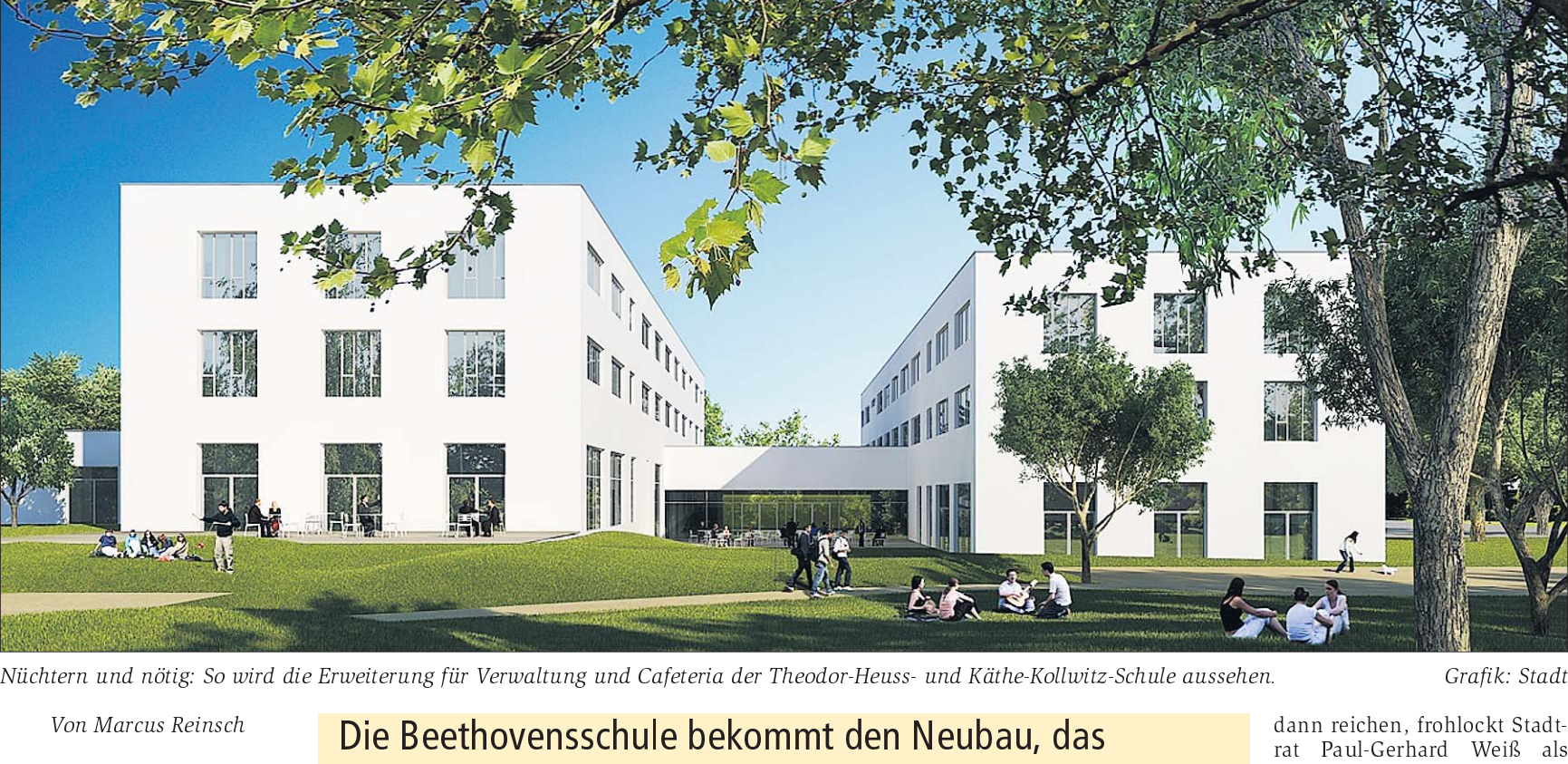
Nüchtern und nötig: So wird die Erweiterung für Verwaltung und Cafeteria der Theodor-Heuss- und Käthe-Kollwitz-Schule aussehen.
